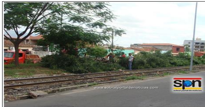
Figura 4- Desmatamento para instalação do VLT em Sobral-CE
